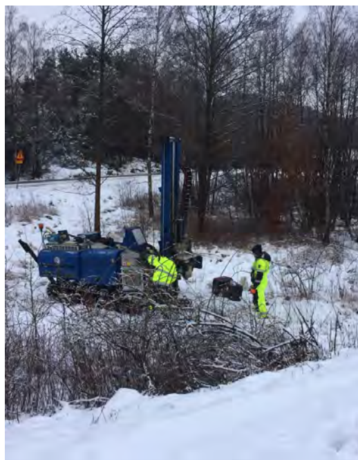
Figur 14. Provtagning och installation av GV-rör i 18ÅF06.
